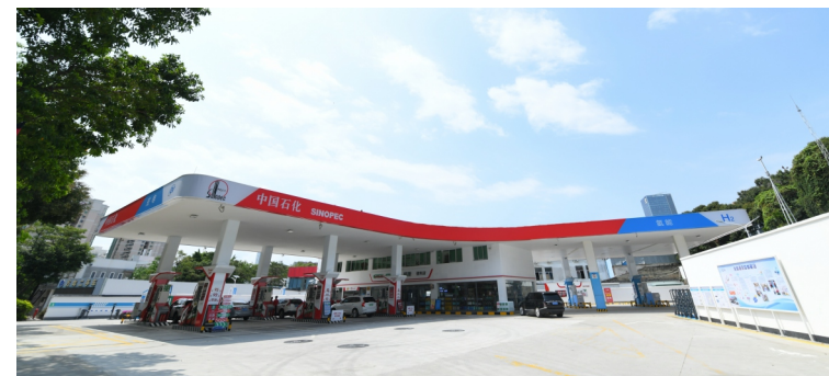
龙珠源综合能源补给站
