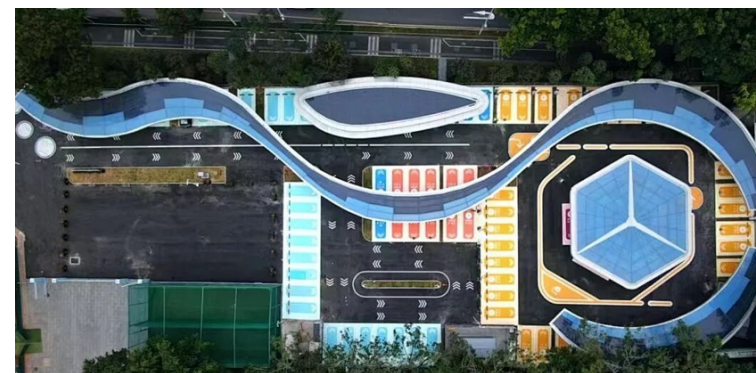
中山公园棒球场光储超充示范站
